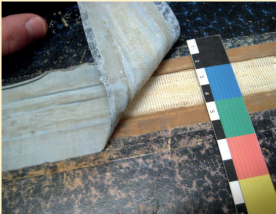
Estado de la lomera antes y después de los trabajos de restauración.
